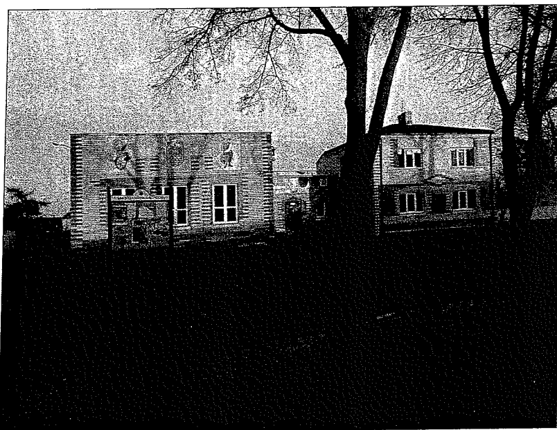
Zdjęcie nr 8. Miejsko-Gminny Ośrodek Kultury w Wąchocku, fot. InicjatywaLokalna.pl
