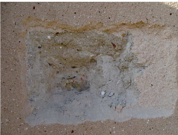
fot. 16: jedna z odkrywek na elewacji południowej, reprezentatywna dla większości z odkrywek na elewacjach; widoczne obie warstwy tynku z VII fazy, pod nim mur kamienny bez zachowanych starszych wypraw, poryty patyną zabrudzeń świadczącą o długim okresie funkcjonowania bez wypraw
