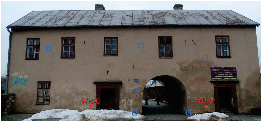
fot. 2: elewacja południowa z zaznaczeniem: □ - wykonanych odkrywek konserwatorskich, ● - pobranych do badań próbek
