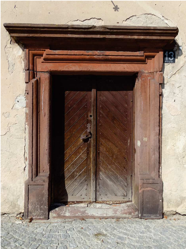
fot. 18: zachodni z portali na elewacji południowej
