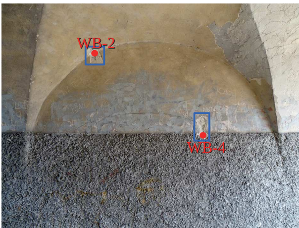
fot. 6: południowe przęsło ściany zachodniej w przejściu bramnym z zaznaczeniem: □ - wykonanych odkrywek konserwatorskich, ● - pobranych do badań próbek
