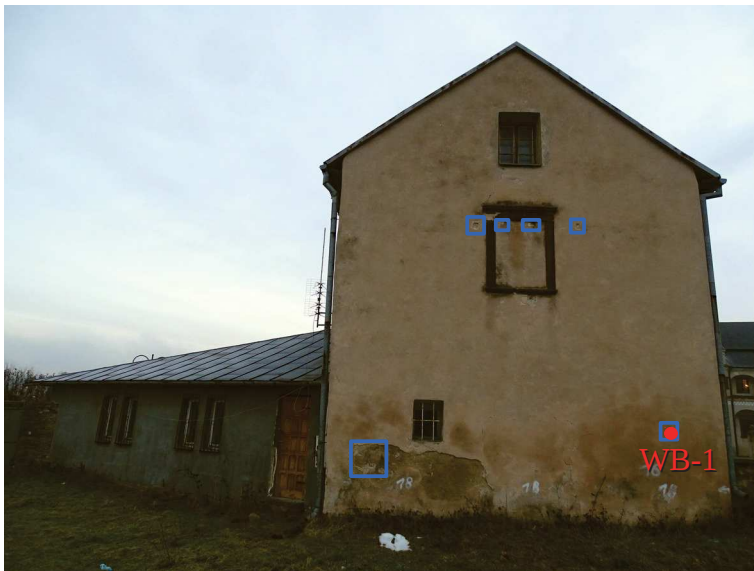
fot. 3: elewacja zachodnia z zaznaczeniem: □ - wykonanych odkrywek konserwatorskich, ● - pobranych do badań próbek
