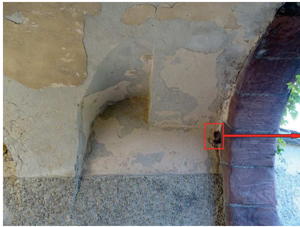
fot. 11: fragment ściany w przejściu bramnym w odcinku północnym, widoczny zachowany jeden z dwóch haków wrót bramy
