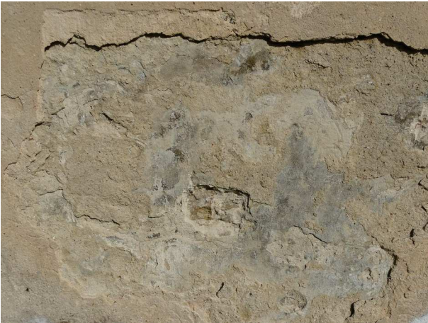
fot. 12: odkrywka na ścianie zachodniej z widocznymi pozostałościami pierwotnego tynku pokrytego relikdami pobiał
